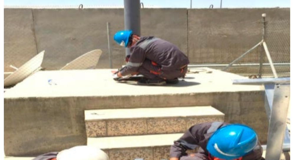
مدّ مخيم الشركة الصينية للهندسة والإنشاءات البتروليّة (CPECC) بأنظمة الأقمار الصناعية VSAT ٢٠١٦ (WQ1 - DS1) / إقليم البصرة
